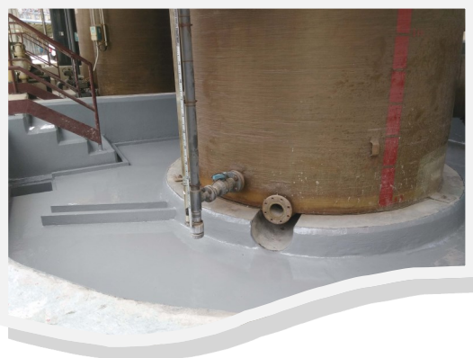
Rehabilitación de piscinas
