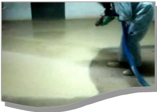
Losas de hormigón
