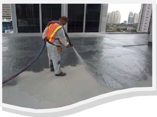
Losas de hormigón
