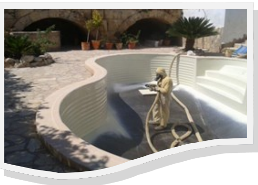
Piscinas de fibra de vidrio
