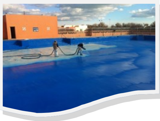
Rehabilitación de piscinas
