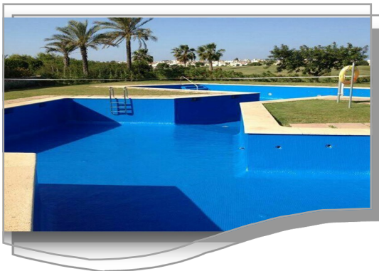
Piscinas de hormigón
